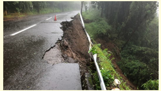
町道425号線法面(谷側)崩落 (2021年7月豪雨時)
